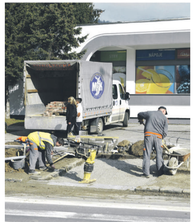
Technické služby v Brezne vybudovali ďalší bezbariérový prístup k chodníku.
