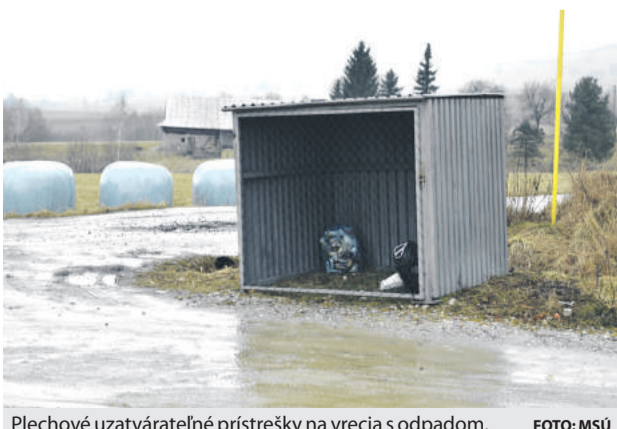
Plechové uzatváratelné prístrešky na vrecia s odpadom. FOTO: MSÚ
