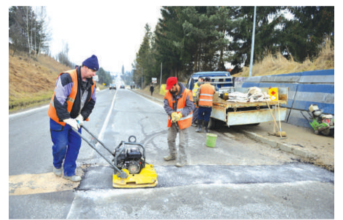
Oprava poškodenej cesty smerom na Mazorník.
