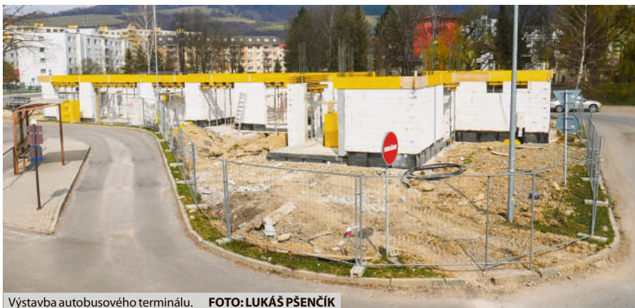
Výstavba autobusového terminálu. FOTO: LUKÁŠ PŠENČÍK
