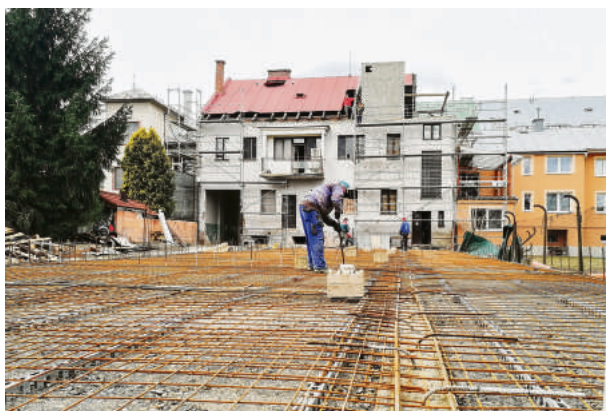
Aktuálne práce na výstavbe zariadenia pre seniorov. FOTO: LUKÁŠ PŠENČÍK
