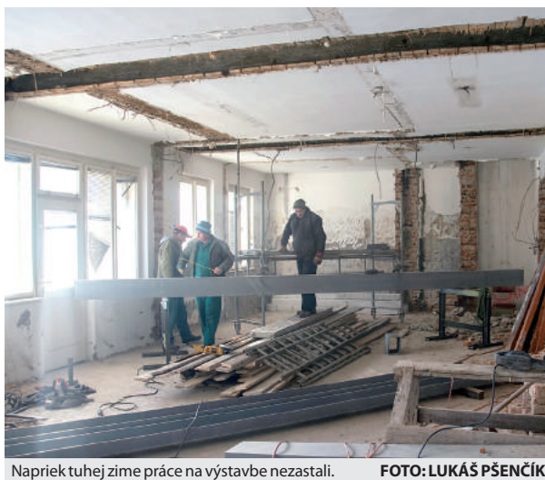
Napriek tuhej zime práce na výstavbe nezastali.
