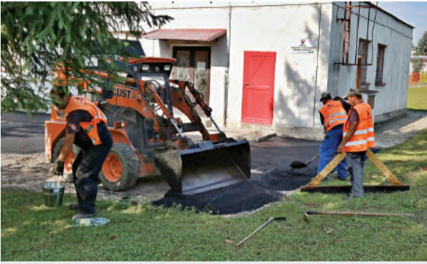
Asfaltovanie na Hradbách.
