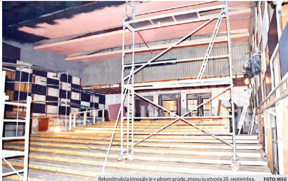
Rekonštrukcia kinosály je v plnom prúde, znovu ju otvoria 20. septembra. FOTO:MSÚ
