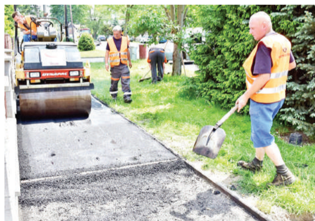
Obnova chodníka na Breznej ulici. FOTO: MSÚ
