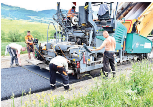
Asfaltovanie na Lúčkach. FOTO: MSÚ
