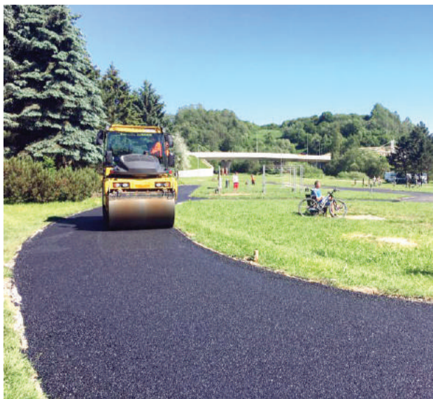
Asfaltovanie na dopravnom ihrisku.
