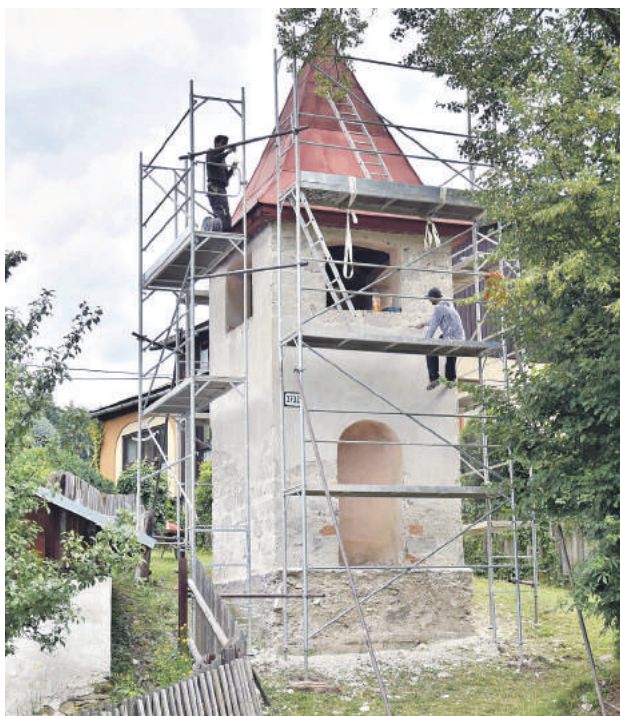
Mesto sa postaralo o renováciu zvoničky.
