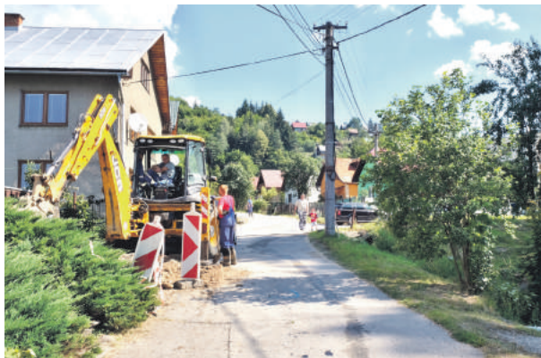
Výmena poruchového potrubia v mestskej časti Gliane.
