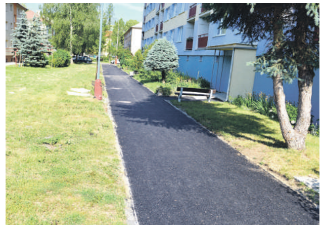
Technické služby už vyasfaltovali chodník na Malinovského ulici.
