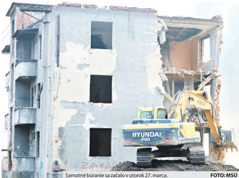
Samotné búranie sa začalo v utorok 27. marca.
