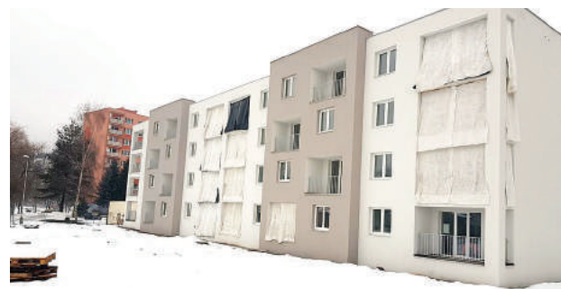
Nájomný dom pred dokončením.
